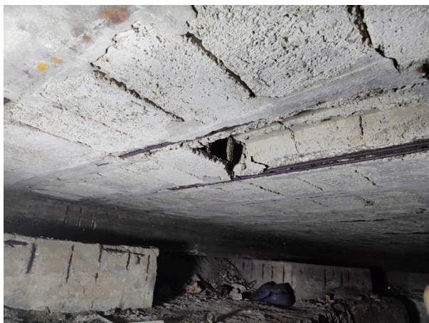
Degrado solaio e armatura travi di collegamento.
