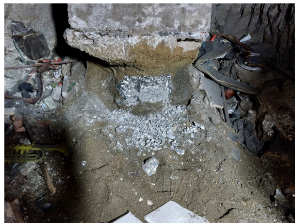
Vista testa palo al di sotto del plinto.
