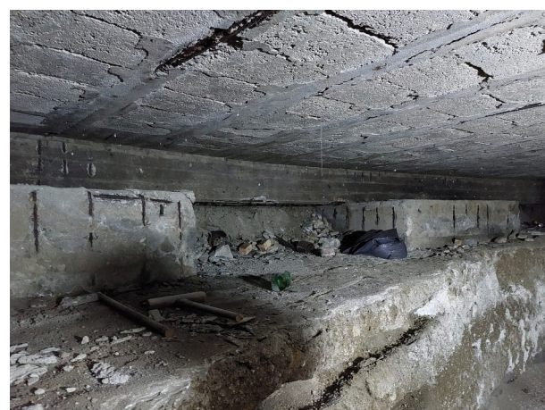
Vista plinti e trave di collegamento.
